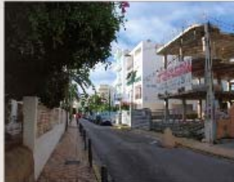
ESPACIO EN CONSTRUCCIÓN QUE DEBERÁ ACABARSE EN OCTUBRE
